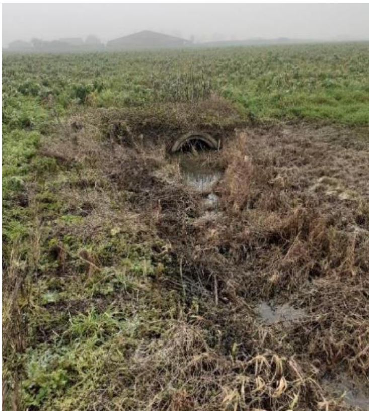
Tronçon amont, entrée dans le premier busage sous voirie RD308 (extrait de la page 12 du dossier)
