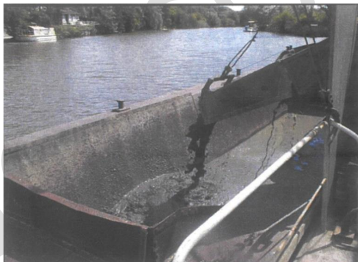
Figure 5 : Illustration d'un transport par barge (source : VNF)
