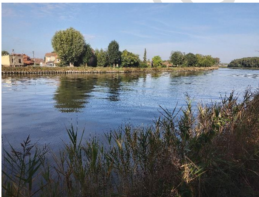
Figure 15 : Photographies des berges en béton (source : BIOTOPE)
