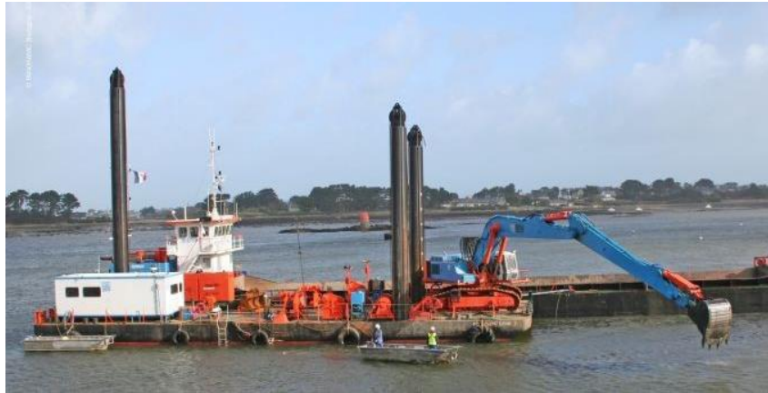
Figure 4 : Illustration d'un dragage mécanique d'une pelle sur ponton (source : VNF)
