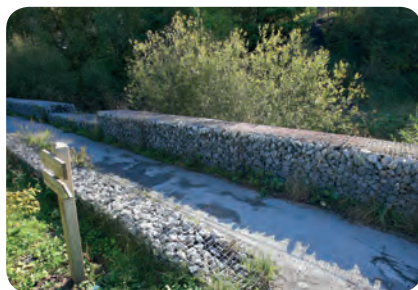
Gabions faits de grosses pierres grises rappelant la couleur du schiste noir, S.Dhote
