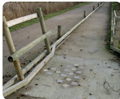
Chemin accompagné d'un fil d'ariane et de reliefs au sol pour marquer un point d'observation ou d'écoute en haut des côtes. Cet aménagement est assez conséquent mais il témoigne de la difficulté de rendre praticable un site pour PMR. Département du Nord
