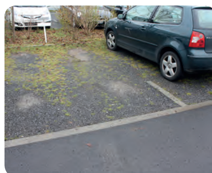
Parking sur gravier filtrant, Mission Bassin Minier
