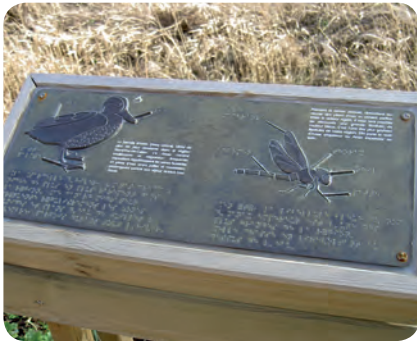
Panneau ludique en relief adapté pour les malvoyants. Pour la partie tactile, le métal a été préféré au bois pour une meilleure résistance à l'usure. G. Lemoine
