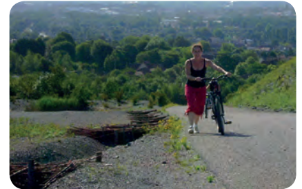
Fascinage le long d'une voie d'accès, Mission Bassin Minier
