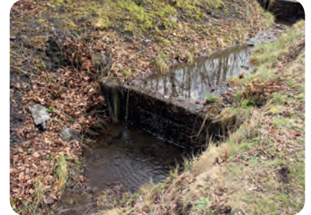
Une succession de palplanches bois ralentissent l'eau en parallèle d'un cheminement, Mission Bassin Minier
