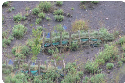
Fascinage sur une pente, BM
