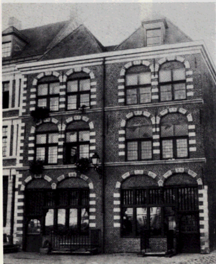
Îlot Comtesse : immeubles du XVII e s., rez-de-chaussée avec châssis et poteaux de bois. Maçonneries en brique et pierre, avec arcs de décharge.
