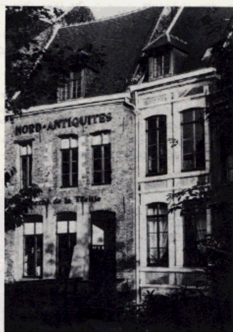
Parvis de la Treille : façades arrière des n°s 23-25, rue des Chats Bossus.
