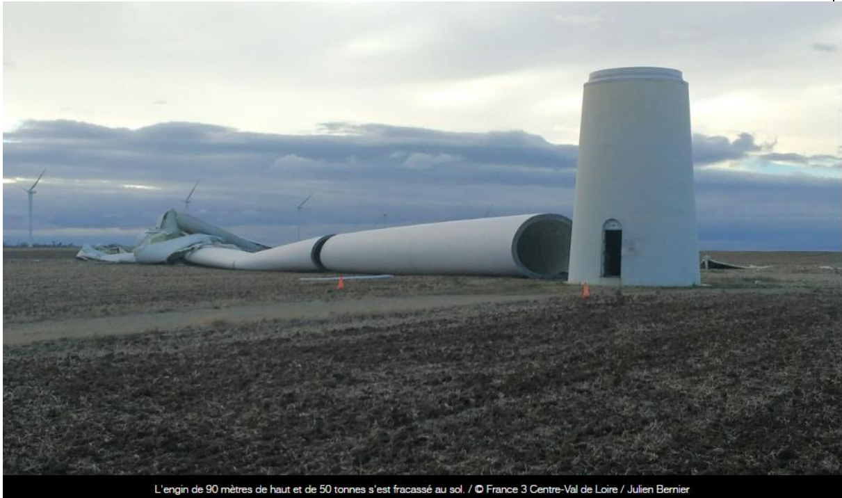
L'engin de 90 mètres de haut et de 50 tonnes s'est fracassé au sol. / © France 3 Centre-Val de Loire / Julien Bernier
