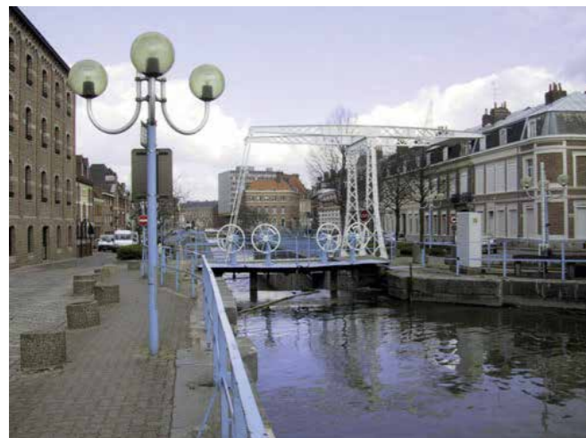
Pont-levis à Douai (Source: @Pir6mon - Wikipédia)
